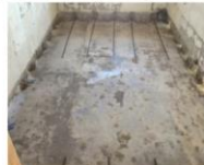
Slika05: Sidranje v opečne zidove
