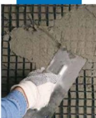
Vgradnja alkalno odporne mreže iz steklenih vlakn Mapegrid G 220 v prvi, sveži sloj malte
