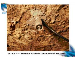
DETAJL "F" - SANACIJA VOGALOV ZUNANJIH OPEČNIH ZIDOV
