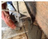
Slika05: Sidranje v opečne zidove
